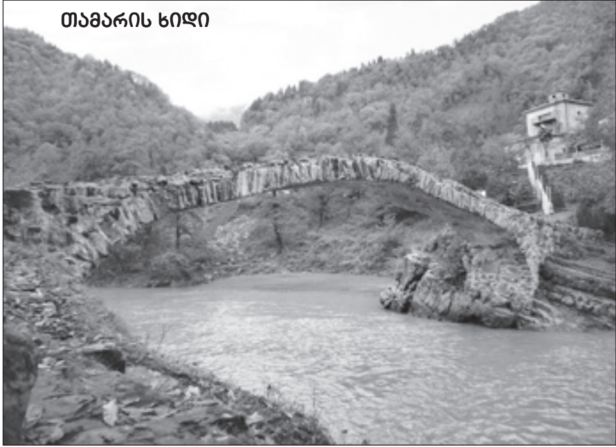
შუა საუკუნეების ქვის სიდი, რომლის აგებაც თამარ მეფის სახელთანაა დაკავშირებული. სიღს აქვს კლიერ დამრეცი კამარა. კამარის მაღი 15.5 მ-ია. ნაგებია კირის დულაბით გამაგრებული კირქვის დიდი კვადრებით. ბურჯები ამოყვანილია კლდეზე. ამ სიდიტ მოსახლეობა დღესაც სარგებლობს.
